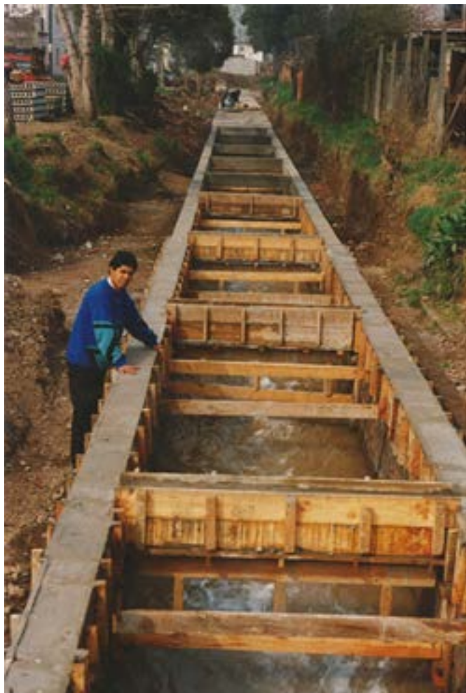
Figura 25. Trabajos de abovedamiento del canal
